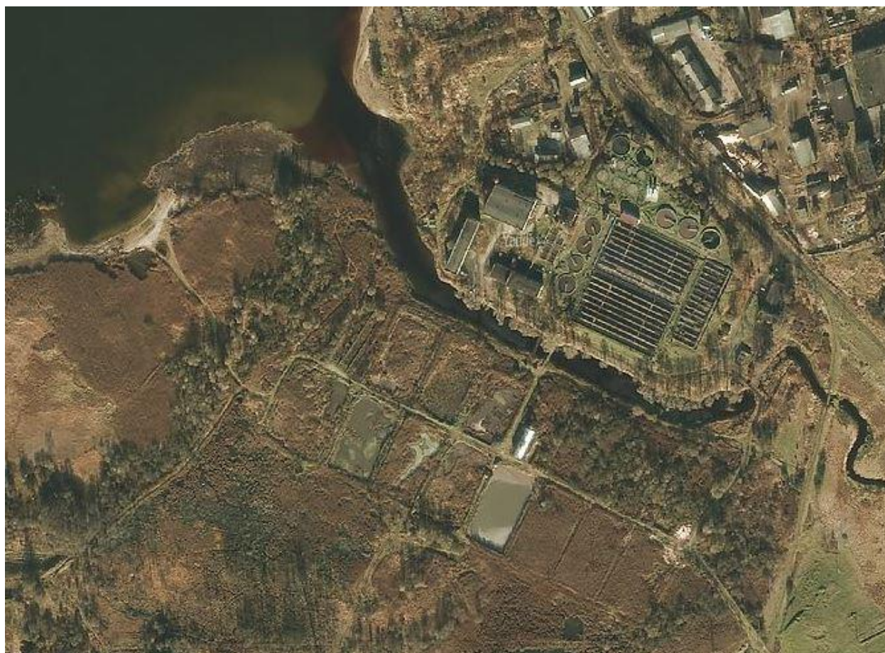
Рисунок 5 – Биологические очистные сооружения (вид сверху)
