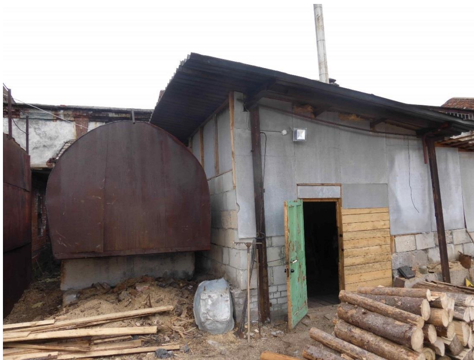
Рисунок 2 – Общий вид котельной
